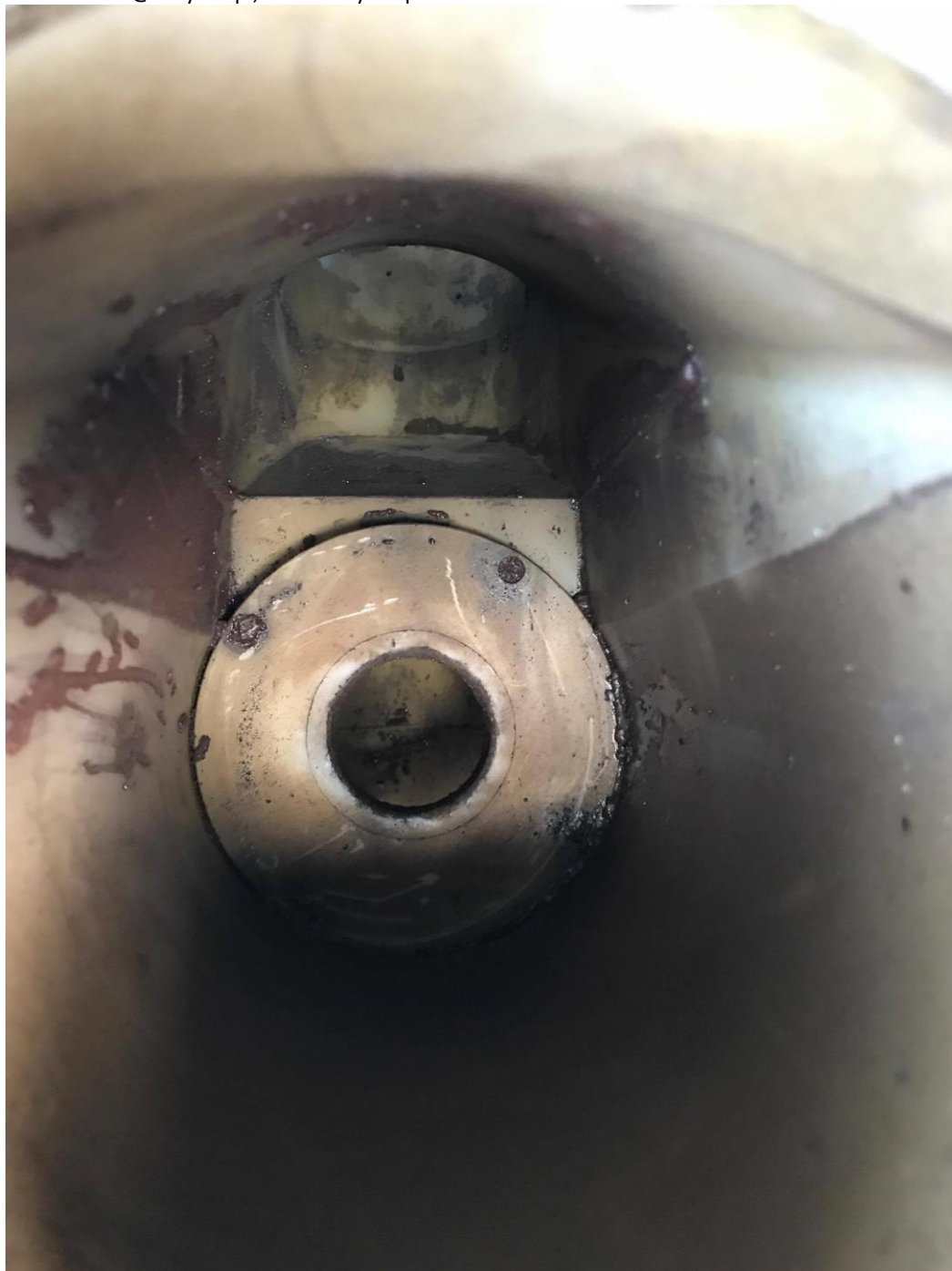
Widoczne uszkodzenia gniazda zaworu
